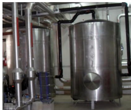
Fig.9 : Photo du stockage et de l'échange d'une installation solaire
